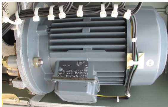
شکل (۴): یک نمونه موتور تپ چنجر
