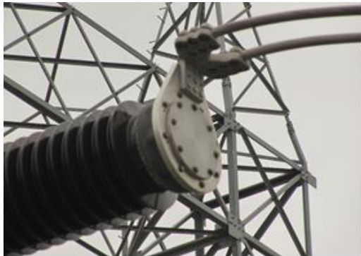
شکل (۳): درپوش انتهایی محفظه قطع قبل از تعویض دریچه اطمینان
